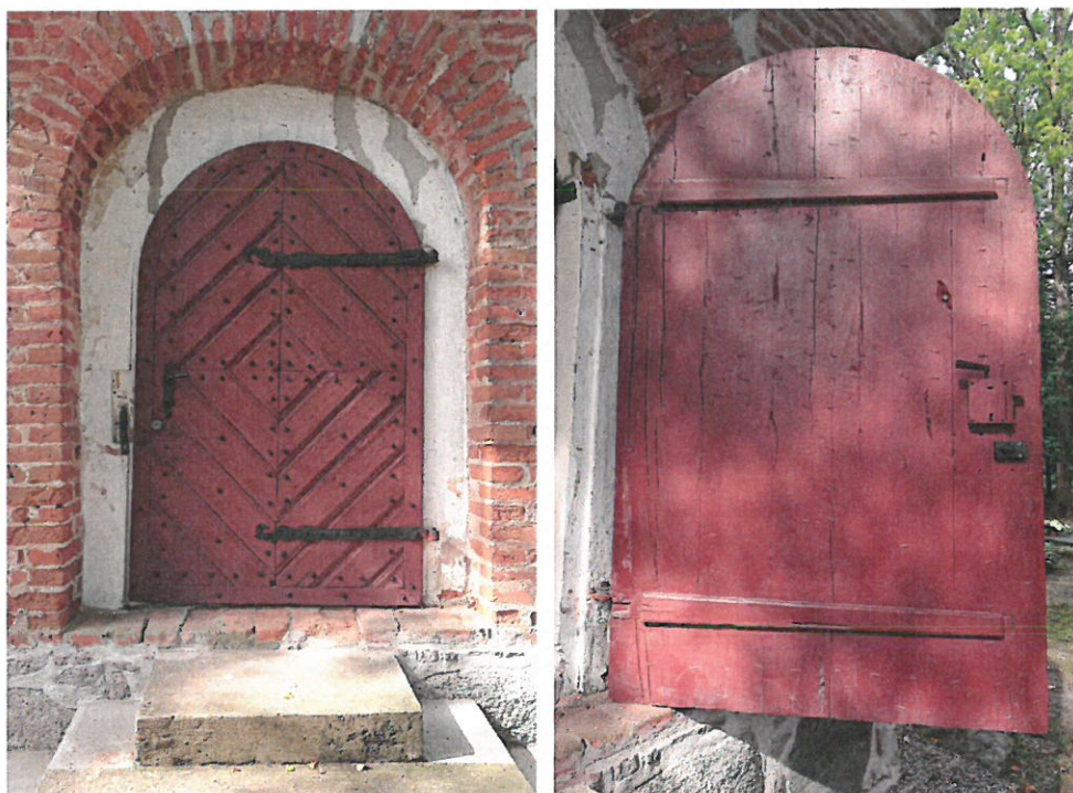
Rys. 2. Drzwi wejściowe, widok odpowiednio od strony zewnętrznej i wewnętrznej
