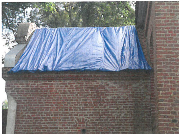
Rys. 2. Wstępne zabezpieczenie nieuszczelnego dachu folią
